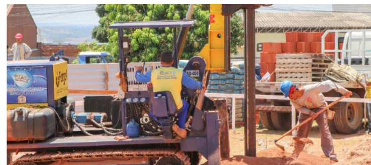
Com cerca de 10% de obras iniciadas, o complexo receberá um investimento de mais de R$ 7,7 milhões para a sua conclusão
