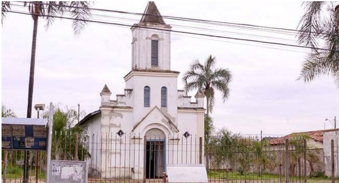
A Igreja São José é considerada a mais antiga da capital. Foi construída em 1901
